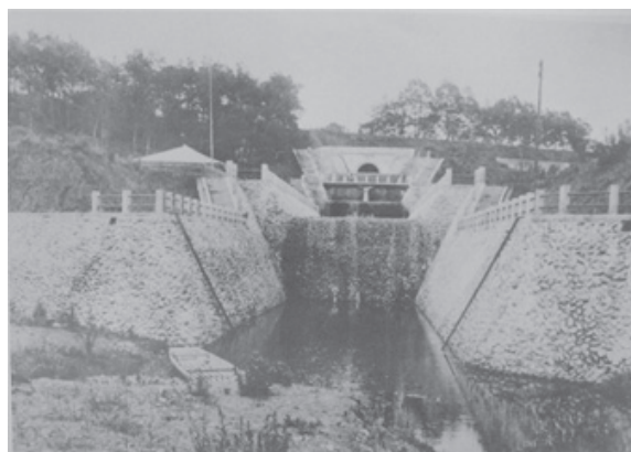
写真 8: 鳩川放水路（新磯村大字磯部地内）
