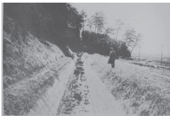
写真 6: 用水幹線（小出村大字芹沢地内）第一号隧道上流
