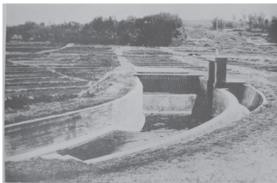
写真 4: 第一号伏越 寒川村大字大蔵・小出村字芹沢地内
