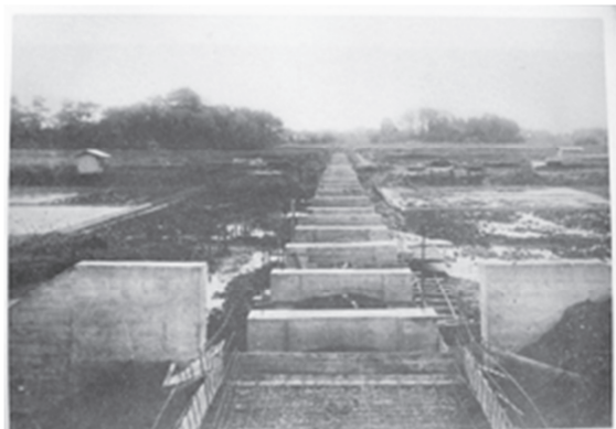
写真 1: 用水幹線（寒川村地内）第一号掛樋工事中
