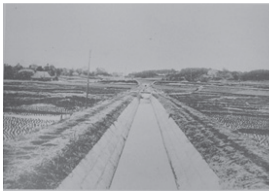
写真 5: 用水幹線（小出村大字下寺尾地内）第二号隧道下流
