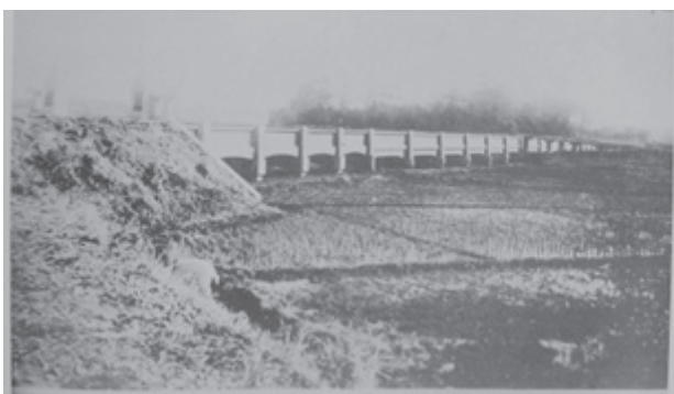
写真 3: 用水幹線（寒川村地内）第一号掛樋（延長 281.0m）
